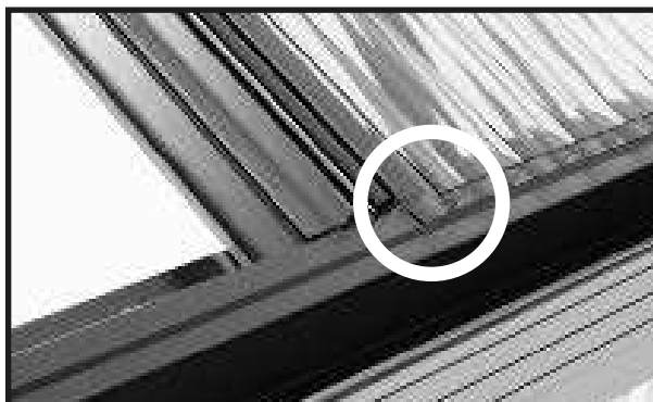
Dettaglio: lastra alveolare sull'aletta di posizione della grondaia.
