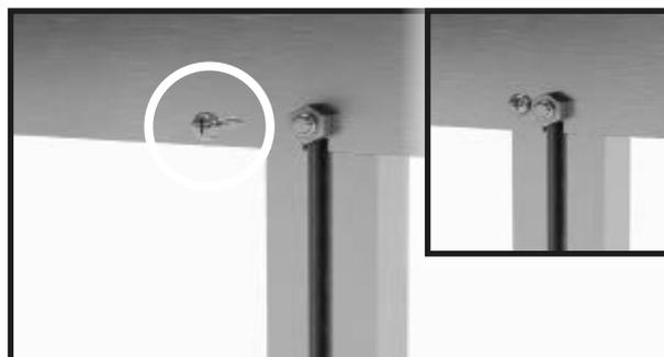
Continuare con il profilo d'ingresso della porta e il puntone trasversale. Avvitare il profilo di ingresso della porta e la traversa con la vite perforante da 4,8x13 mm.
