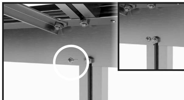
Continuare con la grondaia e i puntelli della parete. Avvitare la grondaia e i puntelli della parete con la vite perforante da 4,8x13 mm.
