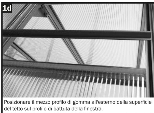
Posizionare il mezzo profilo di gomma all'esterno della superficie del tetto sul profilo di battuta della finestra.
