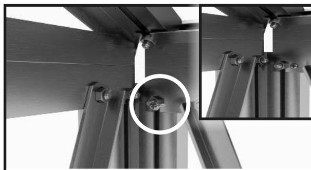
Continuare con la grondaia e i profili angolari laterali. Avvitare il profilo angolare laterale e la grondaia con la vite perforante da 4,8x13 mm.
