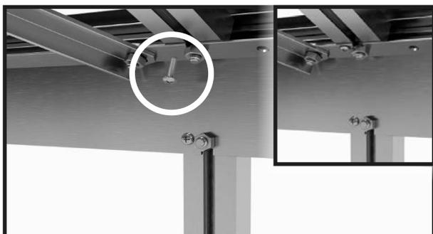
Continuare con la grondaia e i puntelli del tetto. Avvitare la grondaia e i puntelli del tetto con la vite perforante da 4,8x13 mm.
