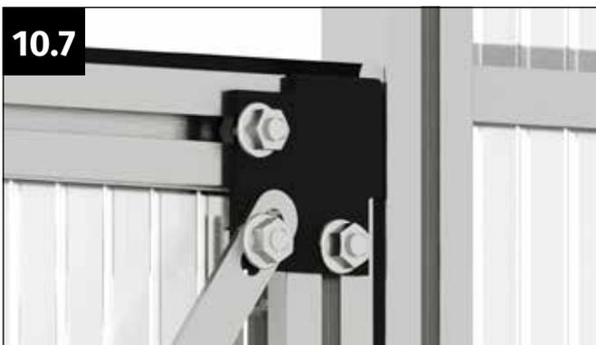
Verschrauben Sie den Diagonalverbinder mit einer Flanschnutter M6. Ziehen Sie die Mutter jedoch nicht fest an!
