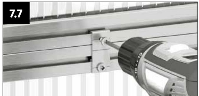
Verschrauben Sie den Verbindungshaken mit den beiden Bohrschrauben 4,8 x 13 mm. Obwohl selbstbohrende Schrauben verwendet werden, empfehlen wir, die Löcher mit einem 4 mm Bohrer vorzubohren.
