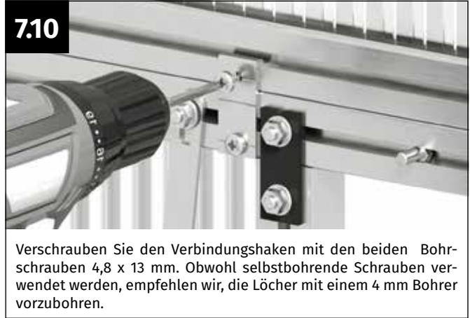
**7.10** Verschrauben Sie den Verbindungshaken mit den beiden Bohrschrauben 4,8 x 13 mm. Obwohl selbstbohrende Schrauben verwendet werden, empfehlen wir, die Löcher mit einem 4 mm Bohrer vorzubohren.
