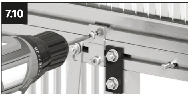
Atornilla el gancho de conexión con los dos tornillos autorroscantes de 4,8 x 13 mm. Aunque se utilicen tornillos auto perforantes, recomendamos pretaladrar los agujeros con una broca de 4 mm.
