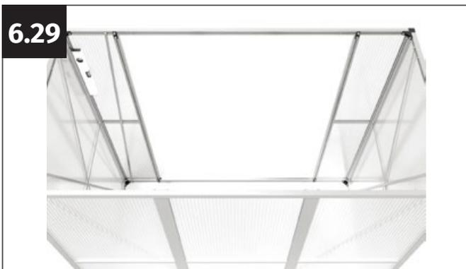
Alignez la paroi avant exactement à l'aplomb et serrez ensuite l'écrou à bride M6.
