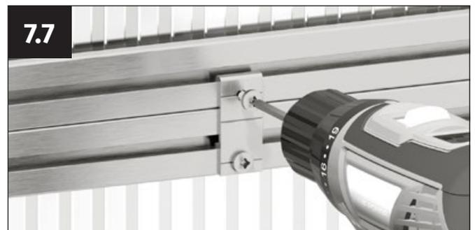
Vissez le crochet de liaison avec les deux vis autoperceuses 4,8 x 13 mm. Bien que des vis autoperceuses soient utilisées, nous recommandons de prépercer les trous avec un foret de 4 mm.
