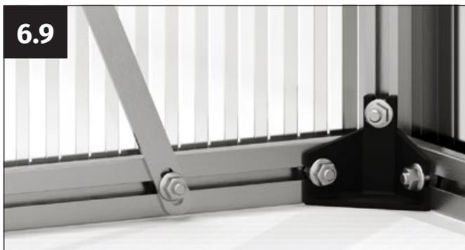
Placez le contreventement sur la vis M6x12 mm de manière à ce qu'il dépasse du trou perforé du contreventement. Vissez le contreventement sans serrer avec un écrou à bride M6.
